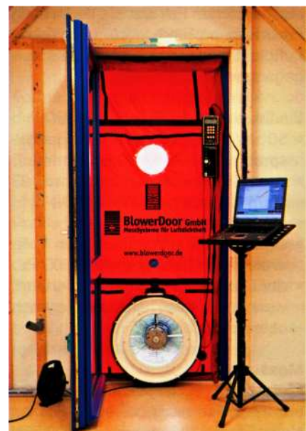
Bild 3.2: Foto einer eingebauten Blower-Door. [Foto: BlowerDoor GmbH]
